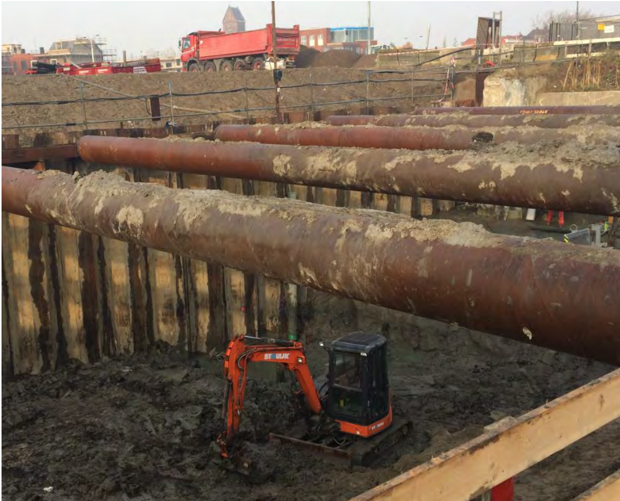
Figuur 13: graven in verontreinigde grond (foto E. van de Giessen)
